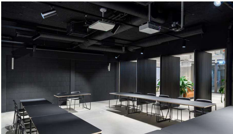
PRISTOP, LJUBLJANA, SLOVENIA / PIPES
