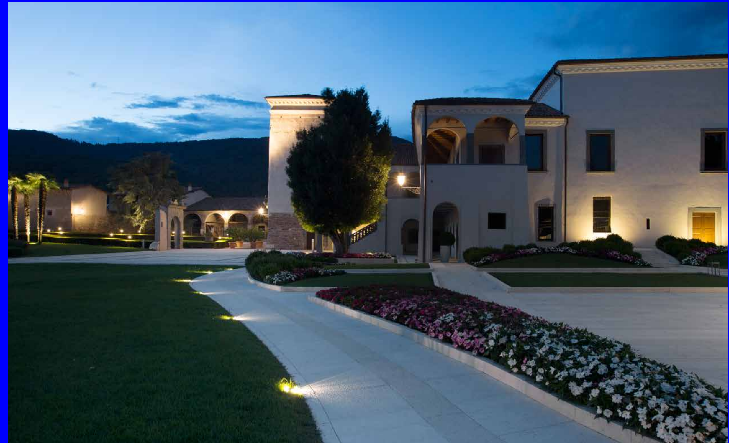
Residenza privata, Monticelli Brusati
